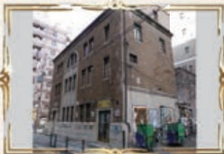
フジハラビル 北区天神橋1-10-4 1923(大正12)年の建築。外壁は味わい深い茶色のスクラッチタイルで、地下1階、地上4階。長窓を配し、中央部に巨大なアーチを装飾的に置いた印象的な外観です。現在はアートギャラリーとして演劇や音楽などのアート活動の拠点となっています。
