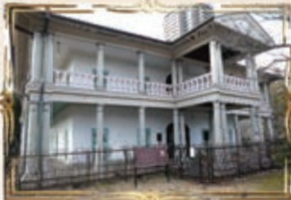
泉布観 北区天満橋1-1-1 国道を挟んで大阪造幣局と隣接する泉布観は、1871(明治4)年、創業当初の造幣局の応接所として建てられました。設計は英国人技師・ウォートルス。白い漆喰塗りの壁が美しい2階建ての建物は総煉瓦造りで、周囲にベランダを巡らせた「ヴェランダ・コロニアル」様式。「泉布」は貨幣、「観」は館を意味し、明治天皇が自ら命名したものです。
