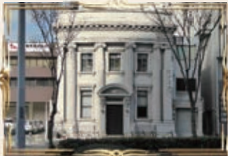
ミナミ株式会社 福島区福島5-17-7 旧川崎貯蓄銀行福島出張所として1934(昭和9)年に竣工。建築家・矢部又吉により設計された西洋古典建築です。古代ギリシャの神殿やヨーロッパの古い街並を思わせる壮麗な建物です。現在はカットソーテキスタイルの販売、企画、製造をおこなうミナミ株式会社です。
