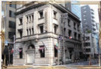
堺筋倶楽部 中央区南船場1-15-12 1931(昭和6)年に川崎貯蓄銀行大阪支店として建てられたものです。当時の銀行建築らしく、重厚感のある切石と左右対称の外観が特徴的で、正面玄関上部の柱が並ぶ装飾は、ルネサンス様式を思わせるデザインです。現在は結婚式もできるレストランになっています。
