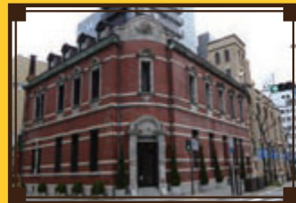
旧大阪教育生命保険ビル (高麗橋ビルディング) 中央区高麗橋 2-6-4
