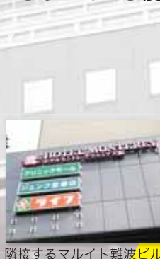
隣接するマルイト難波ビル
